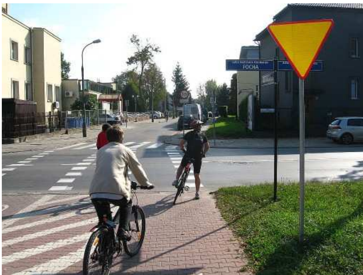
Rys. 5. Wjazd na przejazd dla rowerzystów zlokalizowany na końcu drogi dla rowerów, stanowiącej samodzielny, czwarty wlot skrzyżowania. Pierwszeństwo ustalone znakiem A-7 umieszczonym na wlocie drogi dla rowerów. W tym miejscu powinien znajdować się niewidoczny na zdjęciu znak C-13a („koniec drogi dla rowerów”). Kraków, skrzyżowanie ul. Focha i Kasztelańskiej.
