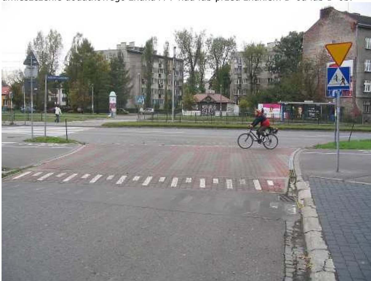
Rys. 1. Przejazd dla rowerzystów prowadzony grzbietem płytowego progu zwalniającego. Znak A-7 umieszczony jest wraz ze znakiem D-6b na wlocie podporządkowanym przed drogą dla rowerów. Próg zwalniający jest doskonałym rozwiązaniem poprawiającym bezpieczeństwo rowerzystów w tej sytuacji. Kraków, skrzyżowanie ul. Monte Cassino i Władysława Mitkowskiego.
